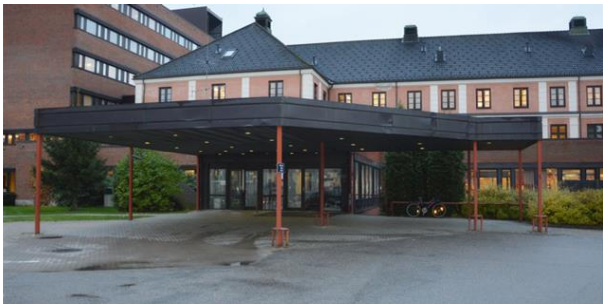
Figur 14 Hovedinngang sykehuset i Elverum. Foto: Sykehuset Innlandet HF
